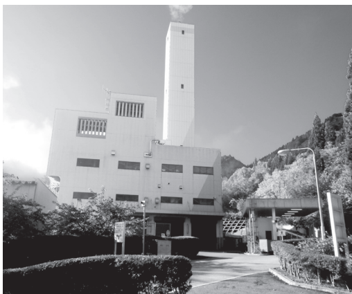
図1 大館クリーンセンター外観
