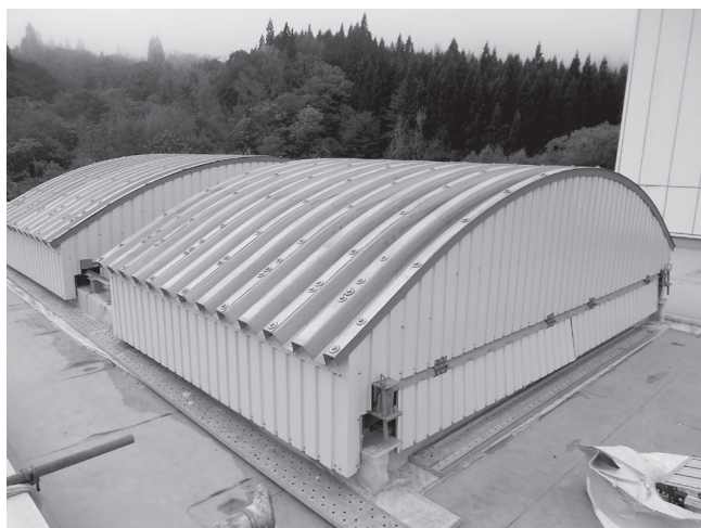
図5 屋根開口 写真
